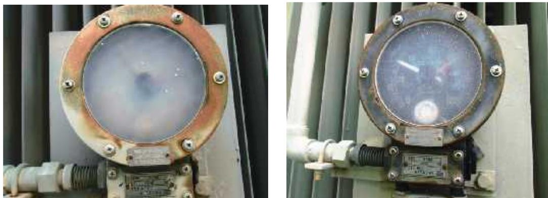
Gambar 5. Gasket dan kaca indikator temperatur yang sudah buram.
